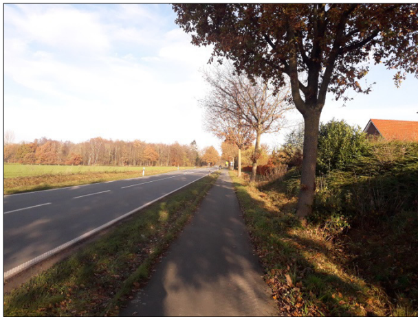
Abbildung 5 Foto: Kreisstraße 173 mit Blickrichtung Nord
