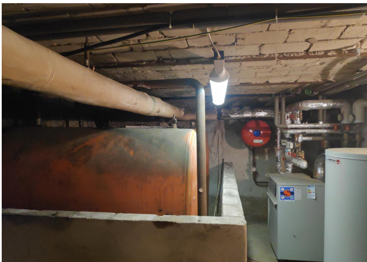
Abb. 4: Blick in den Heizungskeller von Gebäude Nr. 7
