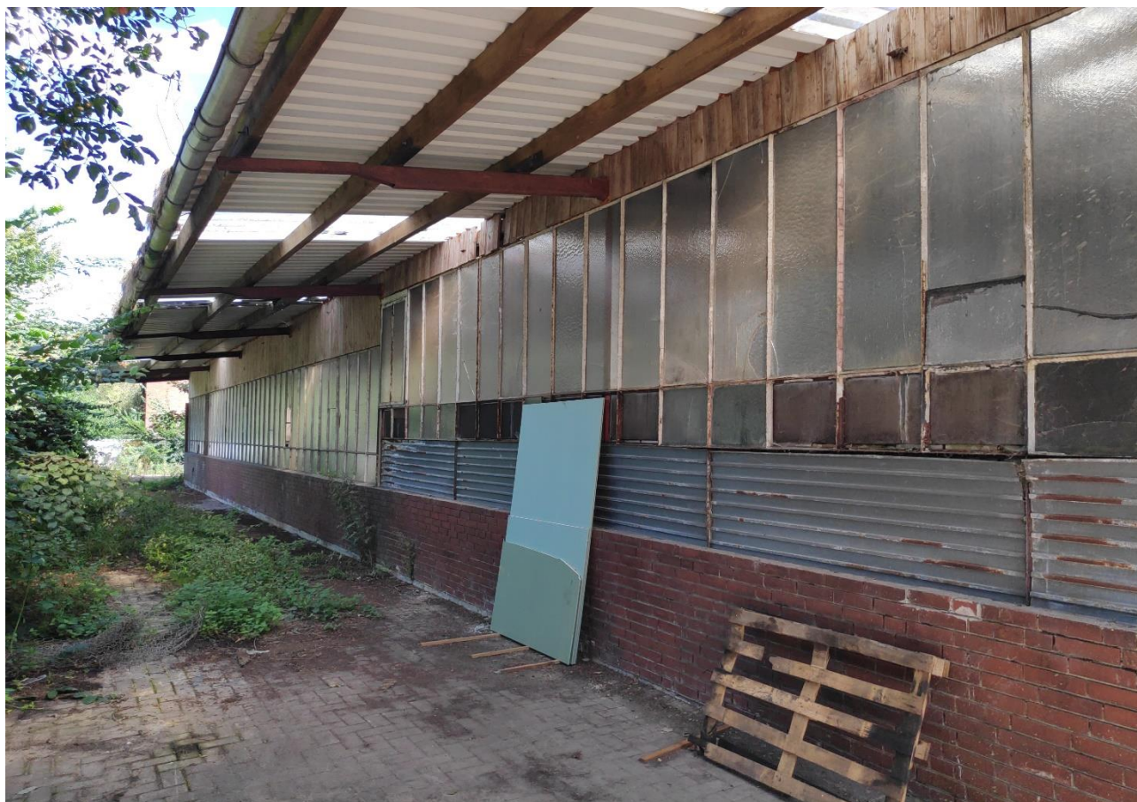
Abb. 7: Blick auf die Rückseite der LKW-Werkstatt.
