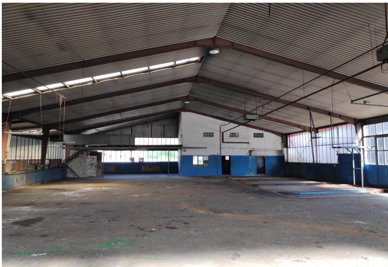
Abb. 8: Blick in die Halle der ehemaligen LKW-Werkstatt.
