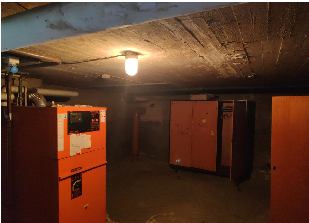
Abb. 5: Blick in den Heizungskeller von Gebäude 9.
