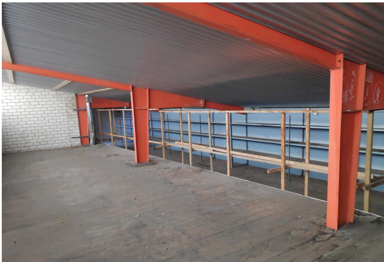
Abb. 6: Blick in den Dachstuhl des Lagergebäudes bei der LKW-Werkstatt.
