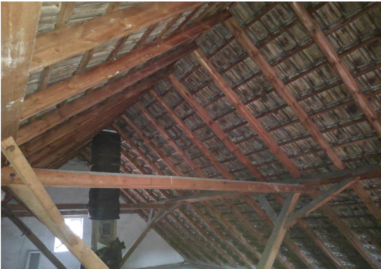
Abb. 2: Blick in den Dachstuhl von Gebäude 11.
