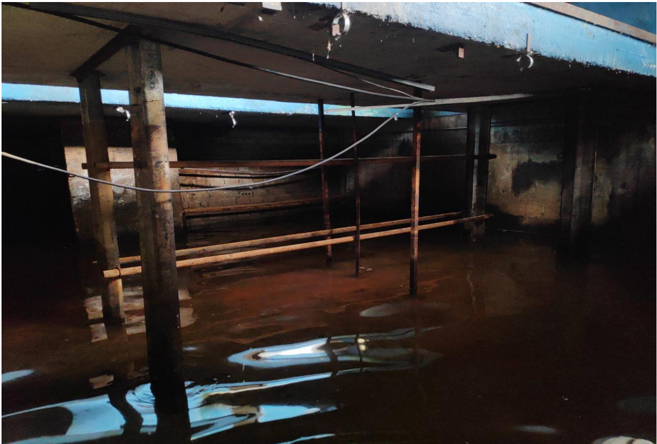
Abb. 9: Blick in die Grube der LKW-Werkstatt.
