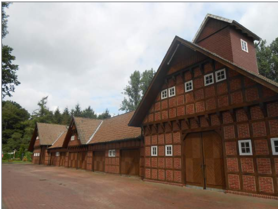
Abb. 53: Hof in ortsbildprägender Bauweise
